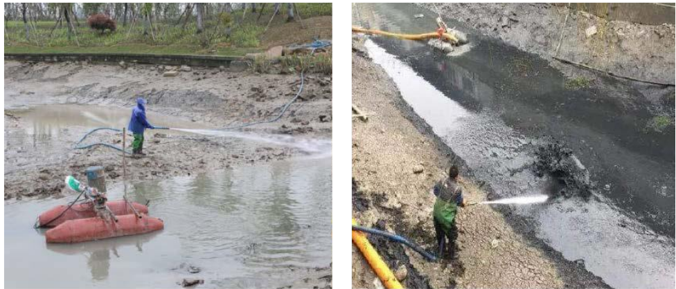
图 2-8 水力冲挖清淤法示意图
