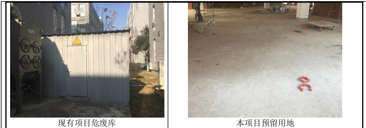
图 1-1 现有项目建设现状
