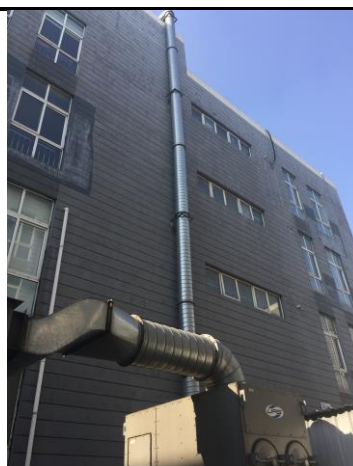
现有项目排气筒
