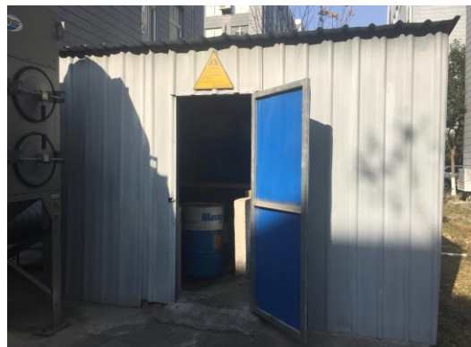
现有项目危废库
