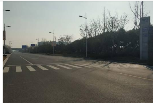
项目西侧通榆南路
